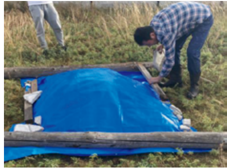
【写真 20】 ブルーシートで覆う
